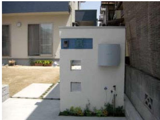
門柱は、表札のインターホン部分を家のベランダ部分と同じ色のタイルを貼り、統一感を出しました。アルミの笠をすることにより塗り壁への雨だれ防止することができます。
